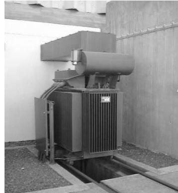
Transformador trifásico interior
